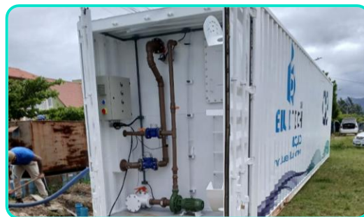
Instalação de dois reservatórios móveis de 70 mil litros para o abastecimento de água na região da Pinheira e Bela Vista.
