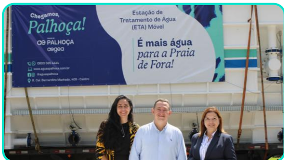
Instalação de ETA móvel, ampliando em 20 L/s a capacidade de produção e reforçando a segurança hídrica da região da Praia de Fora.
