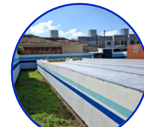
ETE Porto das Águas
